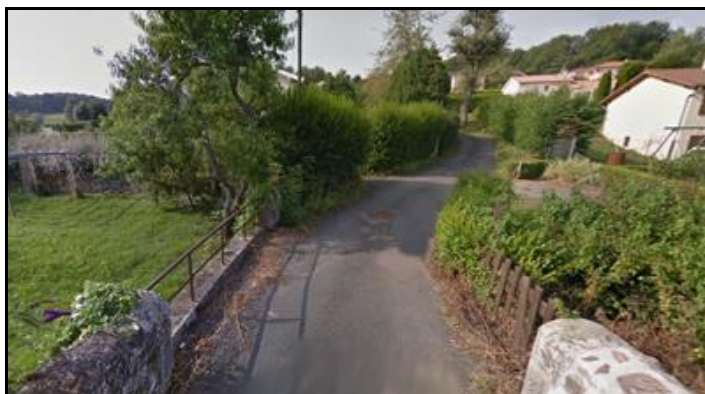
Et là, le pont sur le chemin du Parc
