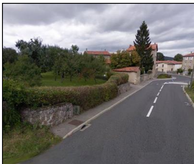
Ce mur surmonté d'une haie est le parapet du premier pont sur le chemin des Verpillères
