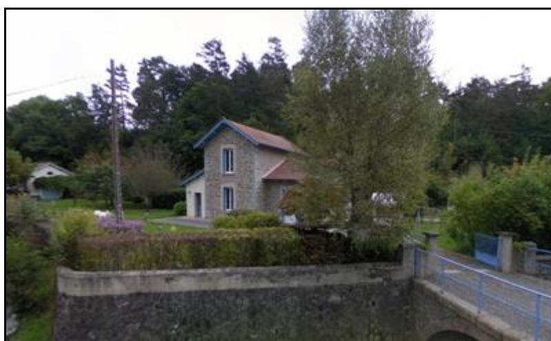
La station avec son pont d'accès, vue côté cour de la gare
